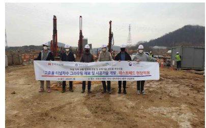
< 인천도시철도 4공구 적용 현장 >
